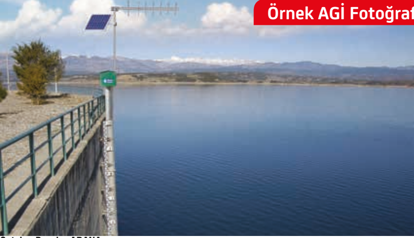
Çatalan Barajı - ADANA
